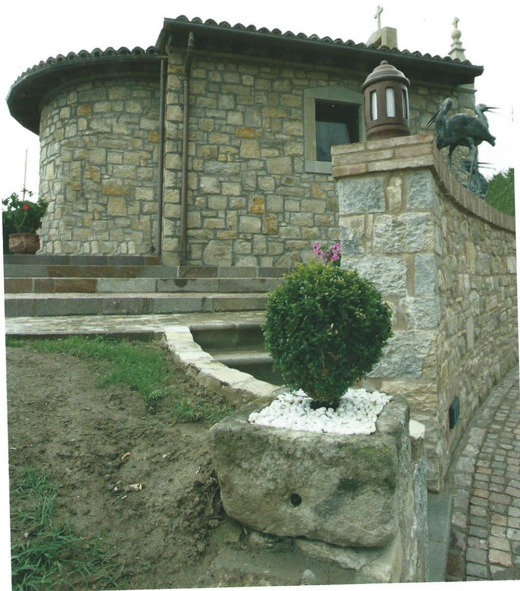
Particolari della Chiesa: fiancata sinistra, abside e muro esterno.
